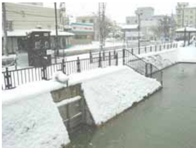
「取水ポンプ施設」
