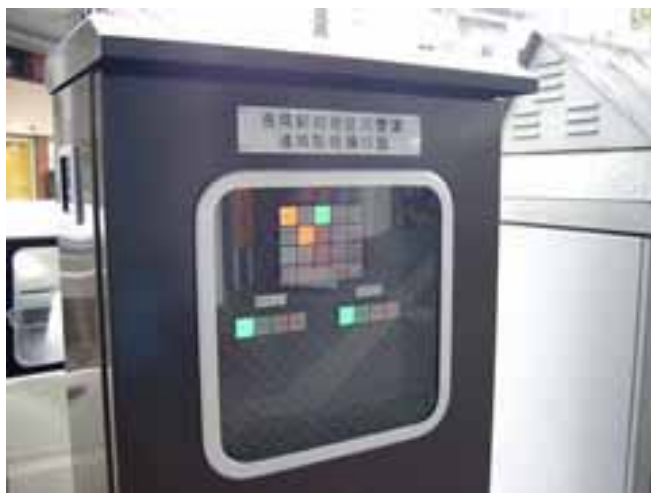
「遠隔監視操作盤」
